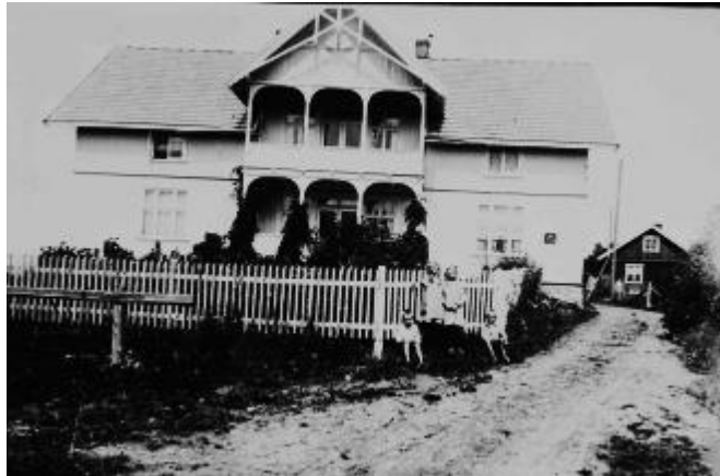
Våningshuset på Oppigarden Bjørke fotografert ca. 1925.
