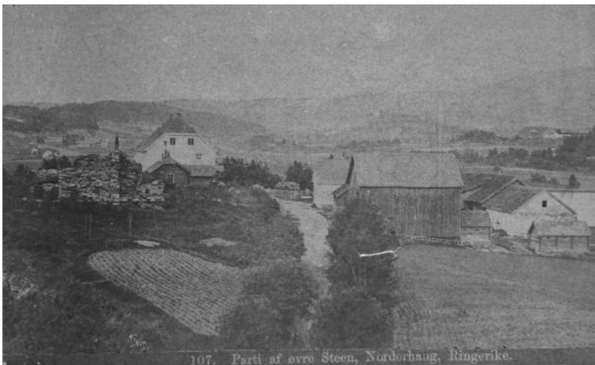
Stein fotografert i 1870-åra. Her ser vi flere mindre uthus, som ble erstattet av den nye driftsbygningen i 1880. Bilde "Hole bygdebok. Bind II" av Gudmund Bakke
