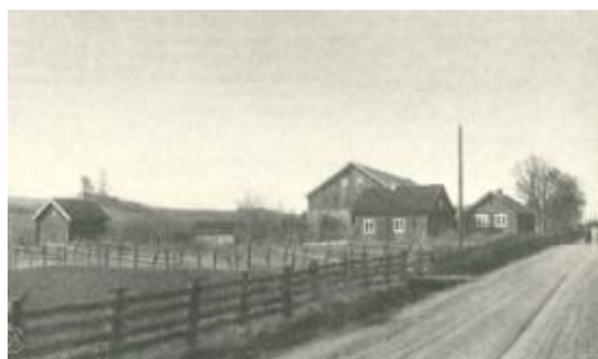
Tunet på Øderå fra "Hole herred 1914". Stua fra Mo er lengst til høyre.
